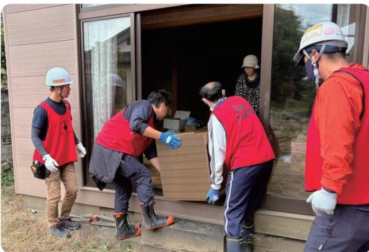
富山市内公費解体予定先での運び出しボランティア
